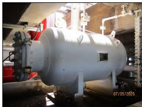
ภาพถ่ายที่ 2.2-6 ถังเก็บรวบรวมน้ำเสียบริเวณหน้าท่าเทียบเรือ
