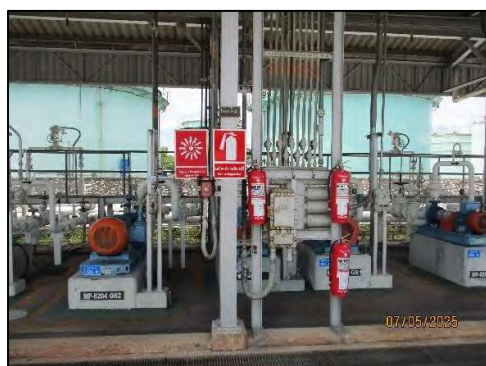
ภาพถ่ายที่ 2.2-19 การติดตั้งอุปกรณ์ป้องกันระงับเหตุอัคคีภัยและอุปกรณ์บรรเทาภัย ภายในบริเวณพื้นที่ปฏิบัติงานคลัง
